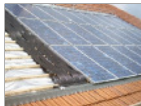
unter Photovoltaik + Solar
